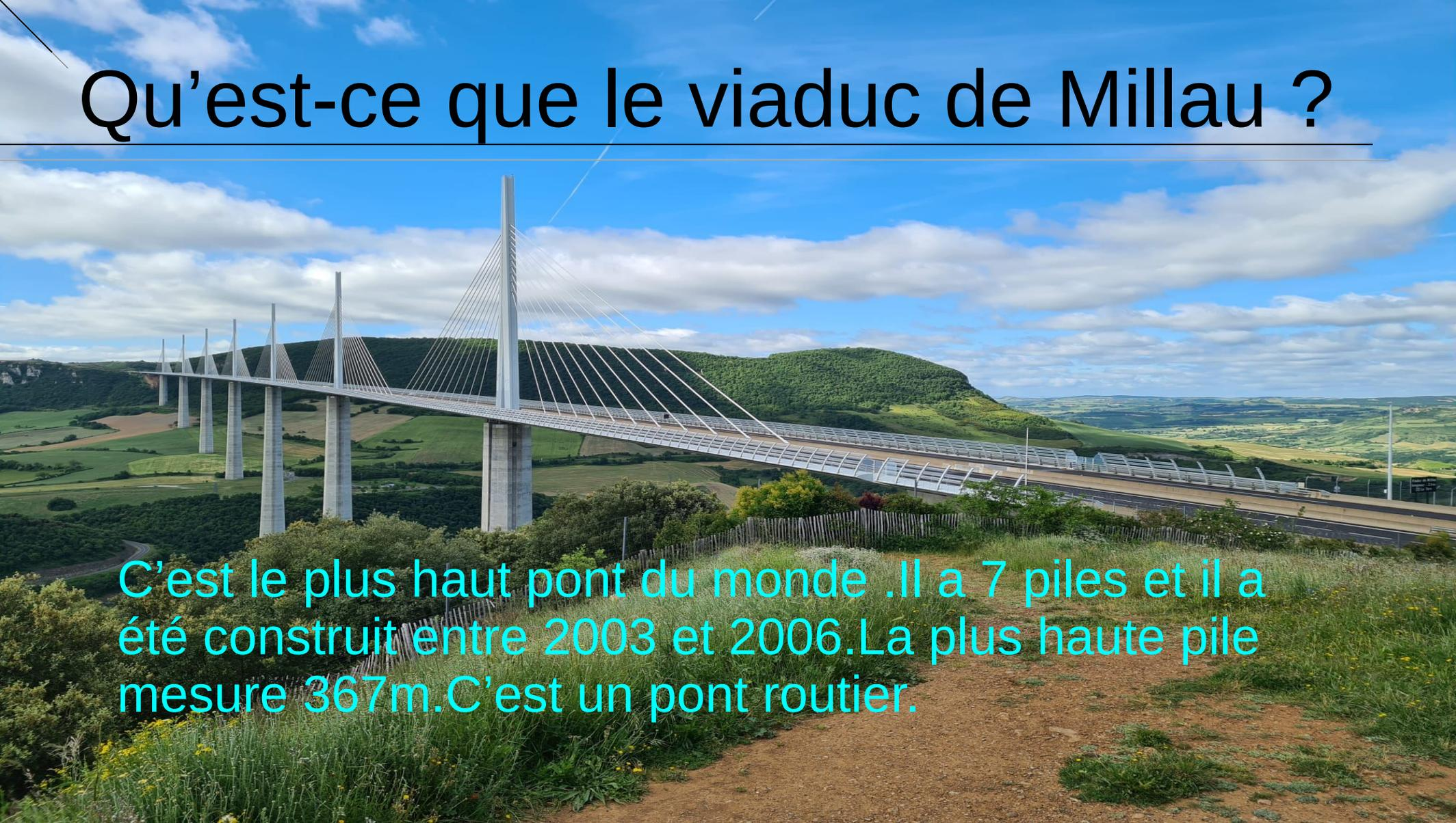
C'est le plus haut pont du monde .Il a 7 piles et il a été construit entre 2003 et 2006.La plus haute pile mesure 367m.C'est un pont routier.
